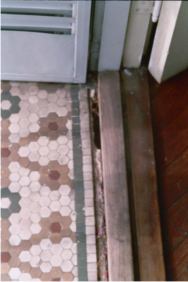
Desprendimiento de material de soporte y premoldeados; anclajes a la vista y oxidados.
