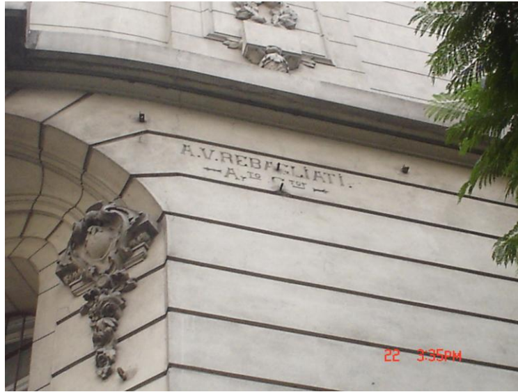
Insertos metálicos de diferente tipo, en el revestimiento símil piedra.
