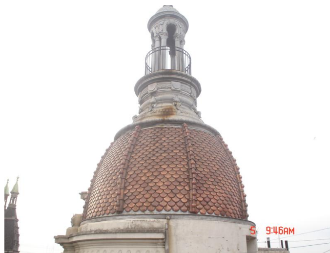
Detalle donde se aprecia el material cerámico de la cubierta
